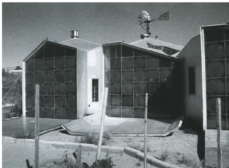
Figure 26. Maison de Steve Bear, Corrales, Nouveau Mexique, vue extérieure des murs d'eau. (Mazria 2005)
