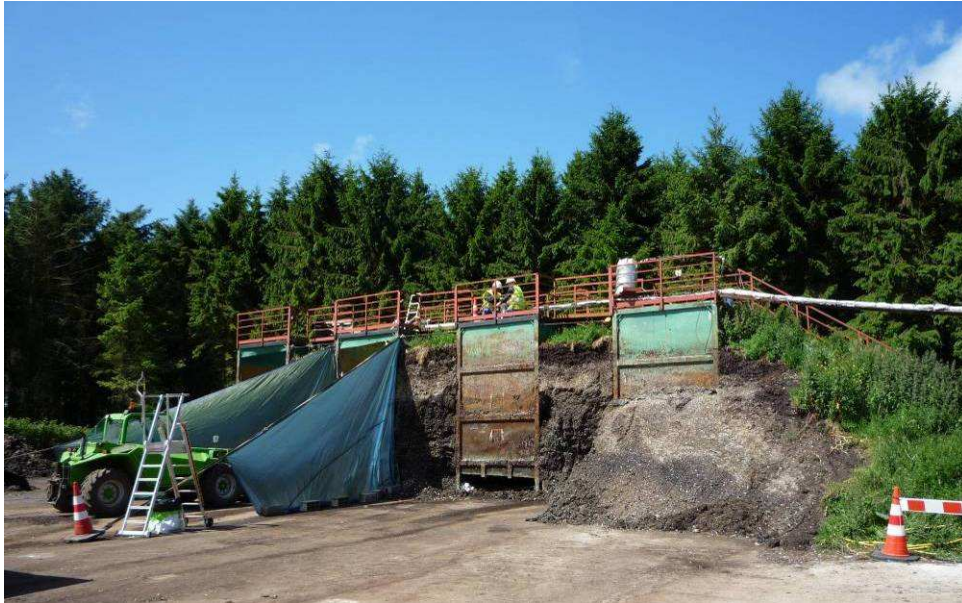
Figure II-16 : pilotes ELIA lors de leur excavation.
