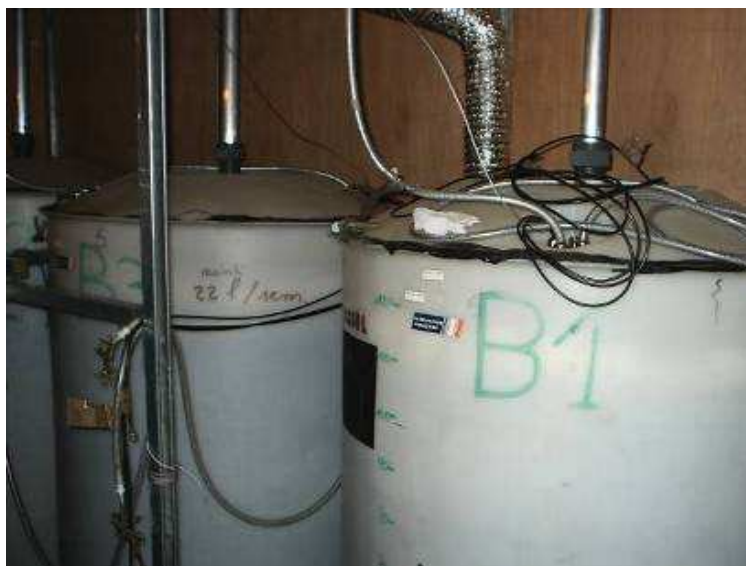
Figure II-17 : pilotes bioréacteurs de l'INSA de Lyon.
