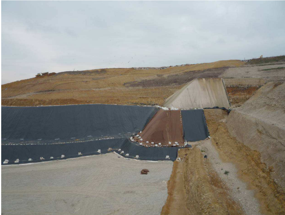
Figure I-12 : photographie d'un casier en cours de préparation d'une ISDND conventionnelle.
