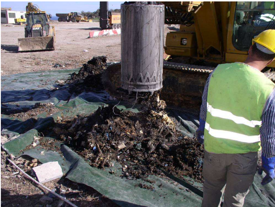
Figure III-2 : forage de déchets profonds sur une ISDND.
