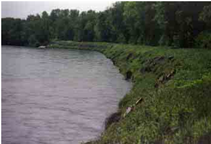
Photographie 20 : exemple d'entretien réalisé par l'association des digues de l'Isère en 2004 sur l'Isère aval (2004, B. Moulin).
