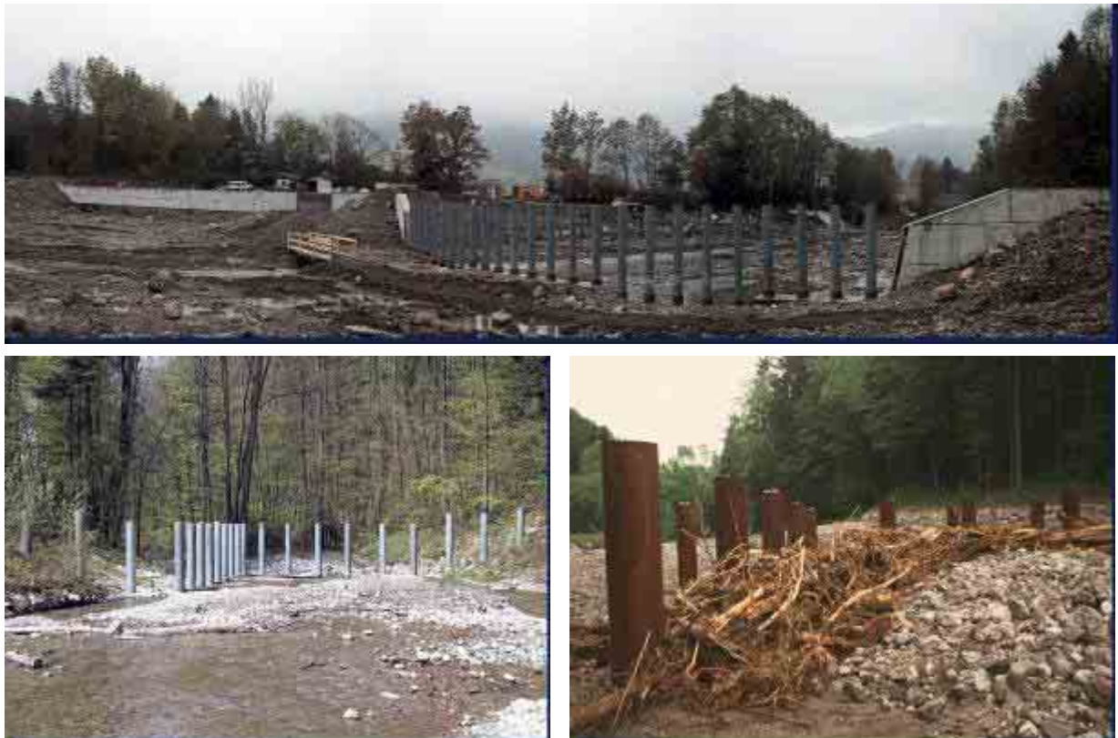
Photographie 34 : Exemples d'aménagements destinés à la rétention des débris ligneux qui ont été mis en place sur des cours d'eau suisses du canton de Zurich (source G.R. Bezzola).
