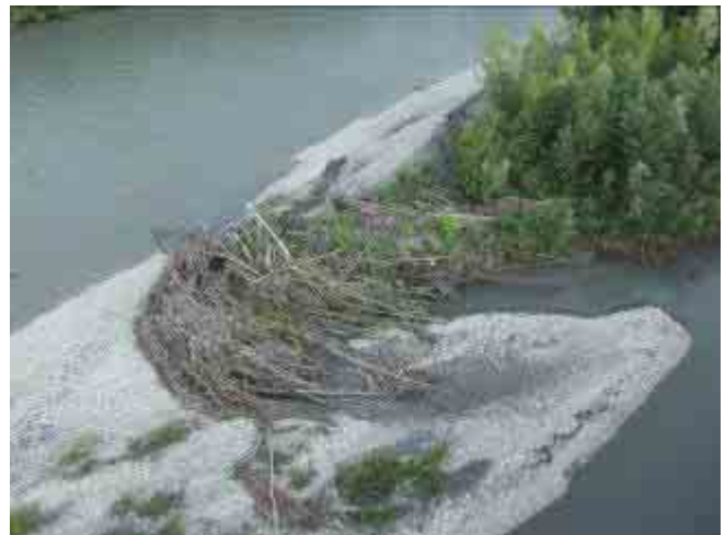
Photographie 12 : Embâcle sur la face amont d'une île (Isère, B. Moulin).
