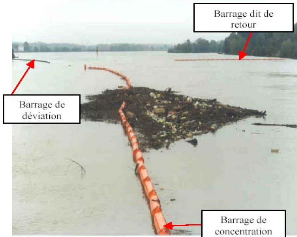
Photographie 17 : Principe de piégeage à l'aide des dromes (EDF).
