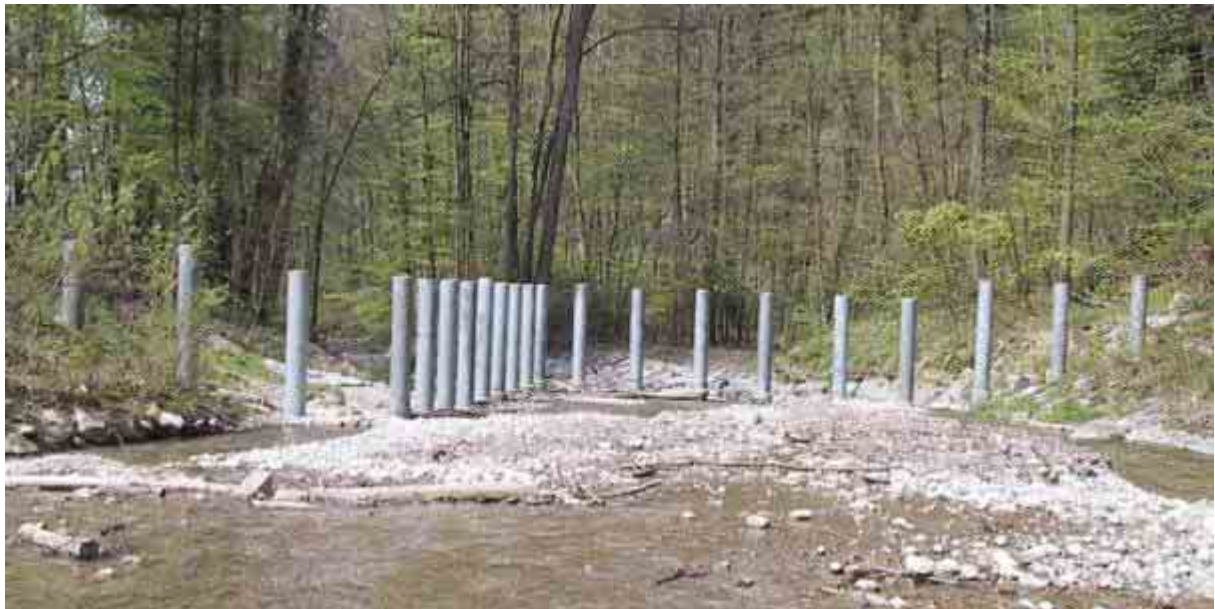
Photographie 14 : Piège à bois mort sur le Chämtnerbach (Suisse, G.R. Bezzola).
