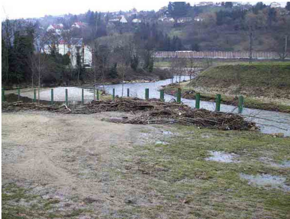
Photographie 16 : Piège à flottants de la commune de Bourgoin-Jallieu (France, M. Boyer).
