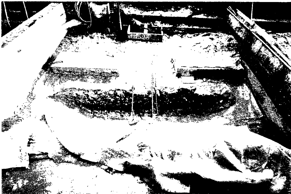
Figure 4.63 - Déchirure de la quatrième nappe de renforcement
