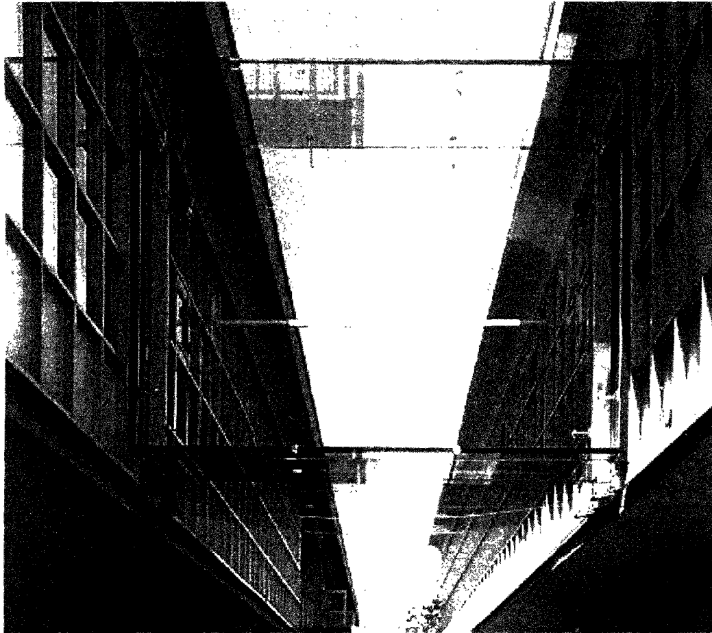
Figure 8 : Vue de côté de la passerelle de Rotterdam
