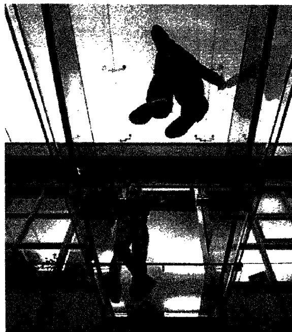
Figure 7 : Vue de dessous de la passerelle de Rotterdam
