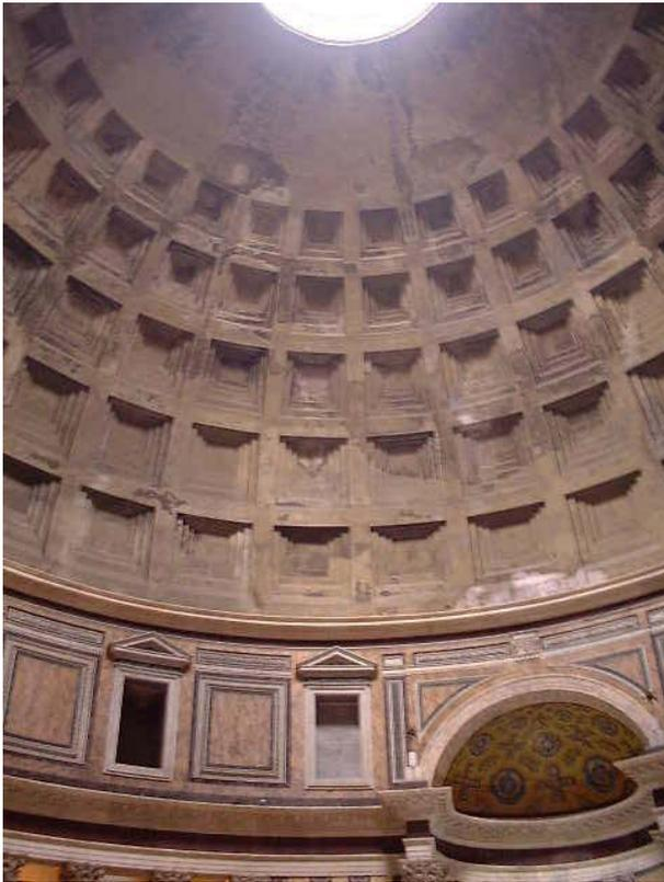
Fig.III.9. La voûte à caissons du panthéon de Rome.
