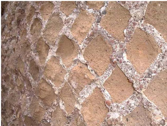
**Fig.III.4.** Joints de parement mis en relief après érosion des moellons de tuf. Mortier de chaux et de tuf volcanique. *Villa d'Hadrien* (Tivoli).
