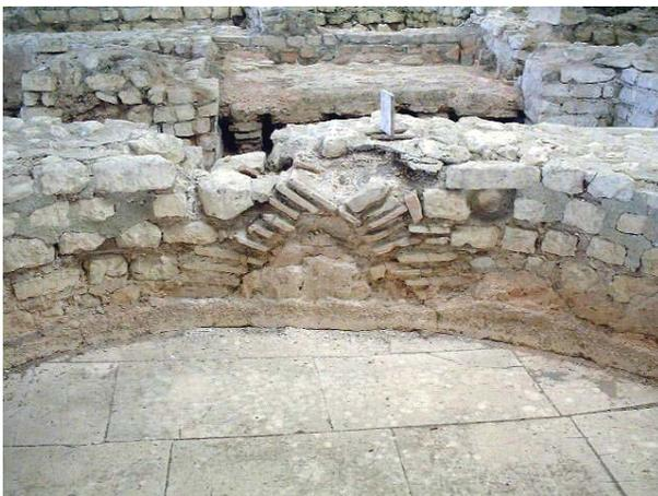
**Fig.III.20.** Piscine E de la *villa* d'Escolives-Sainte-Camille, avec un bourrelet d'étanchéité au pied du mur. On peut aussi observer le conduit de chaleur du mur sud qui est bouché.
