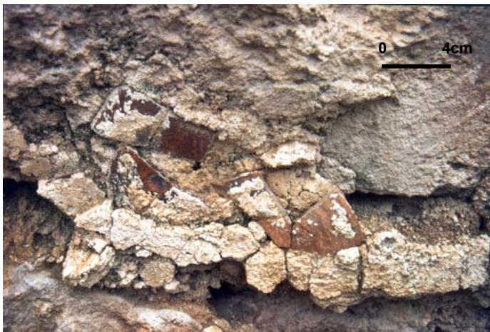
**Fig.III.32.** Tessons de céramiques centimétriques dans le mortier d'un enduit extérieur, autel du temple hellénistique du sanctuaire de Zeus (Jerash).
