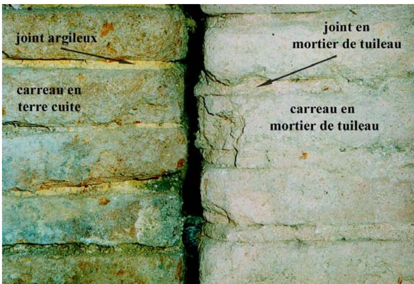
**Fig.III.18.** Salle P3 des thermes de l'Esplanade (Arles). On peut observer les deux techniques de construction des pilettes de l'hypocauste, à carreaux de terre cuite jointoyés avec de l'argile (à gauche) et à carreaux en mortier de chaux et de tuileau jointoyés avec ce même mortier à tuileau (à droite).
