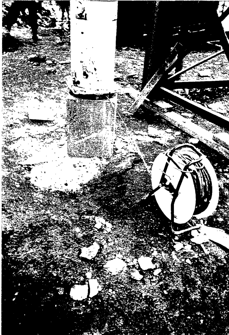
Figure IV.20 : Etat du terrain et de la partie solidaire de la tête du pieu après la rupture.
