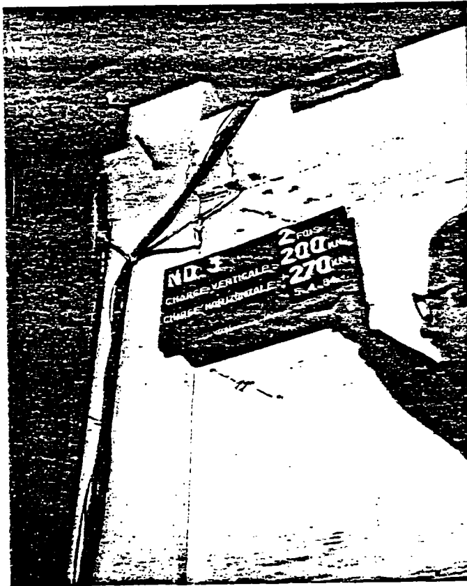
Fig. 3.3.1.4. - DEBUT DE FISSURATION DU CADRE
