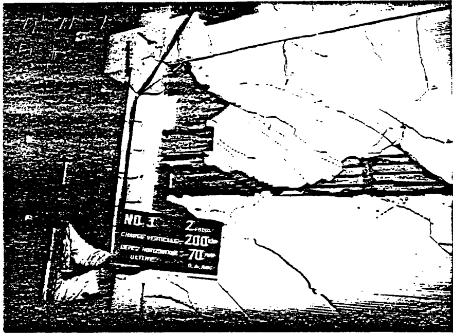
Fig. 3.3.1.10 - ETAT D'ENDOMMAGEMENT DE LA MACONNERIE COTE NORD
