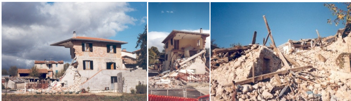
Figure 2. 3 : Dégâts occasionnés par les séismes de la crise de Colfiorito (Italie centrale).
