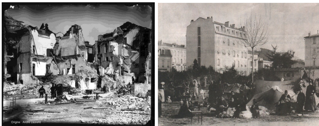
Figure 2. 11 : Photos de destructions dues au séisme Ligure de 1887. A gauche un village de la côte Italienne Ligure, à droite des campements installés dans la ville de Nice. Photos extraites du livre d'André Laurenti [1998].
