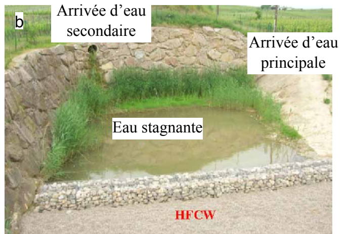
Figure II.3 : Arrivées d'eau du bassin d'orage et points de prélèvement. a : schéma vue de dessus (Source personnelle) ; b : photo vue depuis l'Est (Wanko et coll. 2009).
