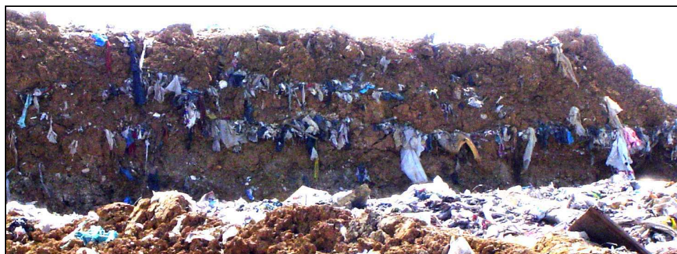
Les couches de déchets stockés et de couverture d'argile
