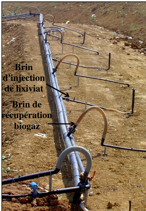
Système d'injection de lixiviat et de captage du biogaz sur site (à gauche), bassin de rétention du lixiviat et débitmètre (à droite)
