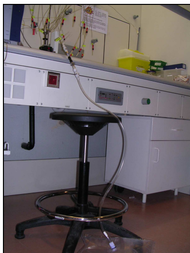
Connexion des poches de biogaz au Micro-GC pour définir la composition du biogaz
