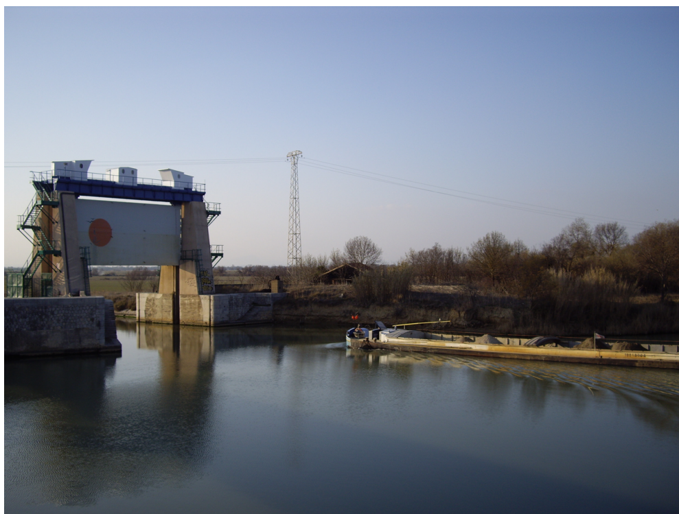
FIGURE 4 – Partie ouest des Portes du Vidourles
