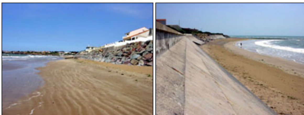
Photographies 60/61 (3/4 sur le plan) : Aménagements de protection contre l'érosion marine (H.D, juin 2003).
