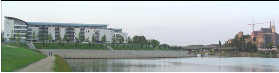
Photographie 50 : Le front de Maine à Angers (réal. Hervé Davodeau, juin 2003).
