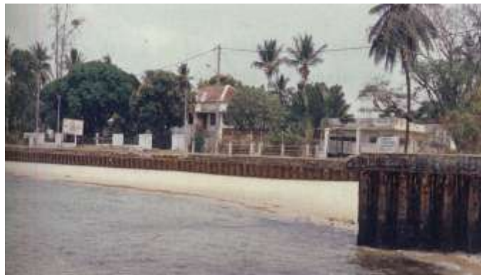
Photo 20 : Rideau de palplanches sur le front de mer de Port-Gentil (Menie, 2007)
