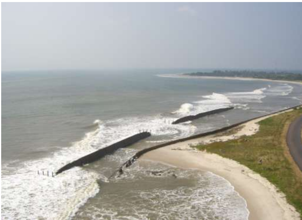
Photo 6 : Aménagement de la pointe du phare par des brise-lames (Menie, 2007)
