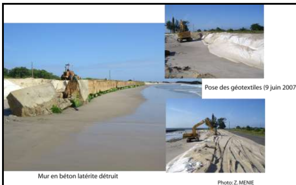
Photo 23 : Le mur de protection en béton latérite au sud du phare
