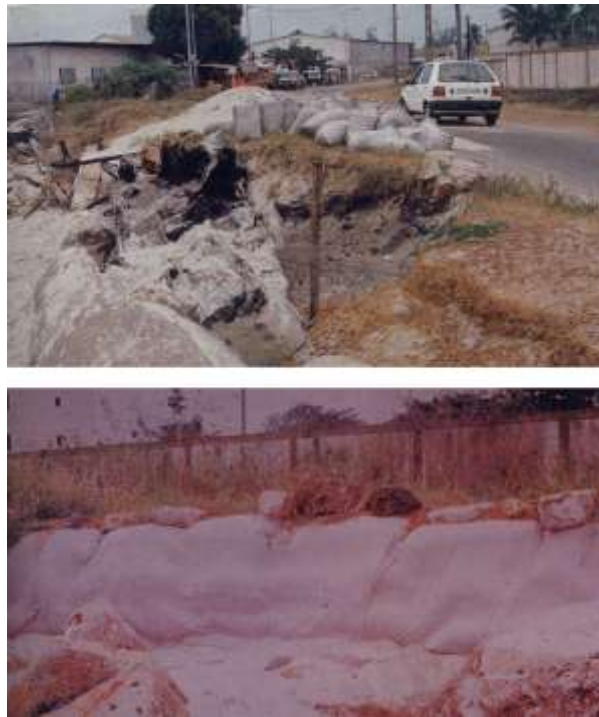
Photo 22 : Protection de la côte par des boudins
