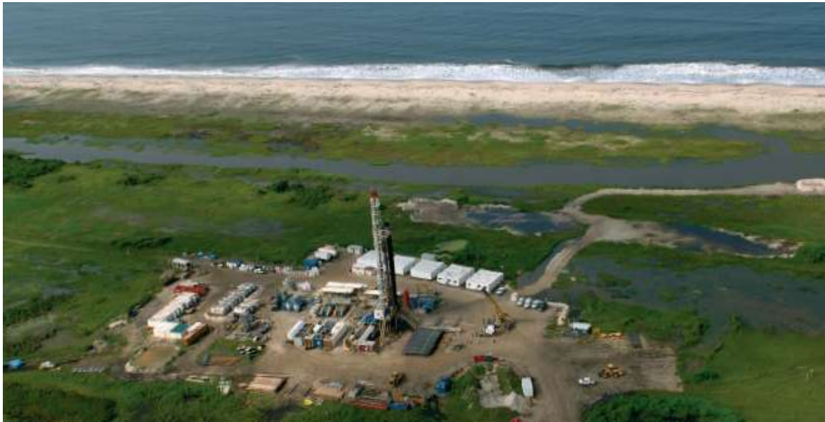
Photo 7 : Forage on shore sur le cordon dunaire à l'Ouest de Port-Gentil-Océan (Total Gabon, 2006)
