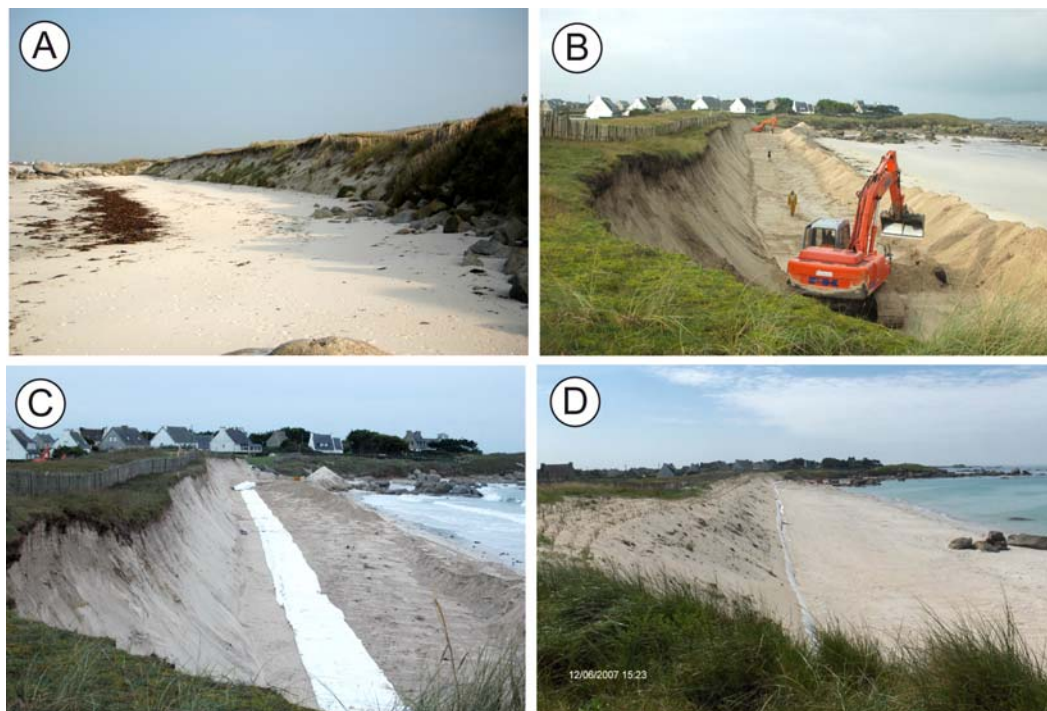
Photo 26. Cordon dunaire de la plage de Boutrouilles. A : versant externe de la dune avant les travaux de protection. On distingue des formes d'érosion telles que des falaises et des éboulements. B : décaissement du pied de dune afin de poser l'encrage du Stabiplage ® (cliché A. Démon, 19/10/2006). C : pose de la structure Stabiplage ® avant injection (cliché S. Suanez, 24/10/2006). D : versant externe de la dune reprofilé et planté d'oyat dans sa partie sommitale (cliché Espace Pur, 12/06/2007)
