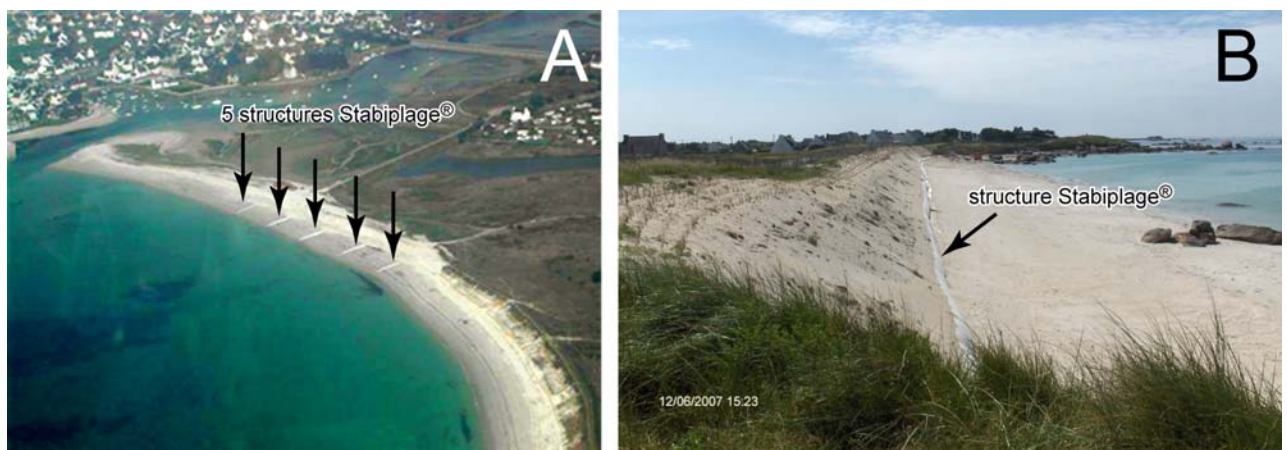
Photo 25. Vue aérienne des 5 Stabiplate® transverses mis en place sur la plage des Sables Blancs (A). Vue oblique du Stabiplate® longitudinal installé en pied de dune de la plage de Boutrouilles (B) (cliché : Espace Pur).
