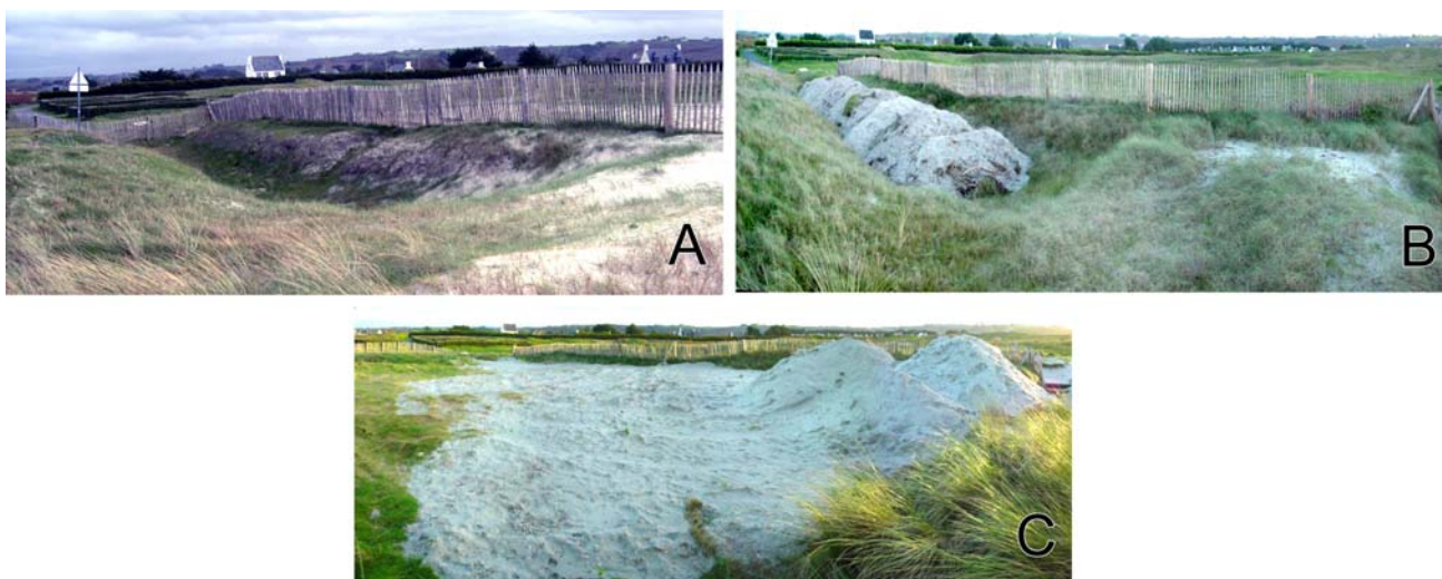
Photo 23. Rechargement et comblement de l'ancien chemin d'accès au camping au travers du cordon dunaire du Vougot (cliché S. Suanez, A : 30/03/2006 ; B : 28/11/2006 ; C : 19/11/2008)
