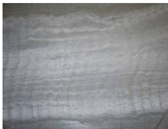
Figure 31. Irrégularité d'aspect dans le câble d'alimentation
