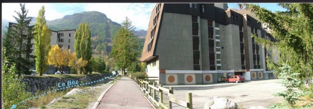
11/10/2007- Emprise urbaine en lieu et place de l'ancienne zone d'emprise torrentielle. Implanté dans les années 1960, l'immeuble "Le Concorde" (au premier plan) est situé à moins de 5 mètres du chenal torrentiel... Vue panoramique réalisée sous Microsoft® ICE.
