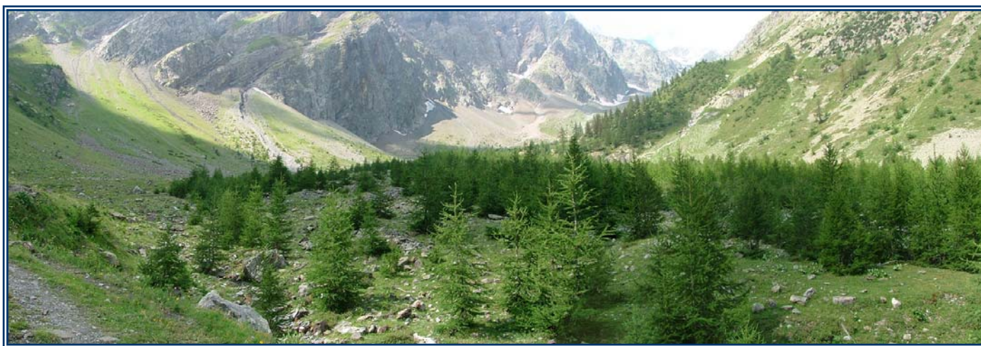
Figure 128: Section supérieure du torrent du Grand Tabuc, stabilisée et spontanément végétalisée au cours de la période contemporaine.
