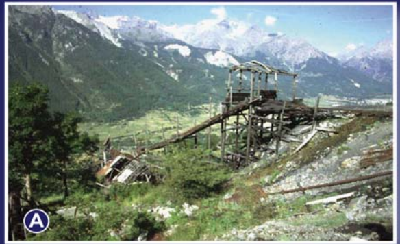
A- Ruines aujourd'hui démantelées des installations minières de "Pierre-Grosse". Source: Société Géologique et Minière du Briançonnais (SGMB).
