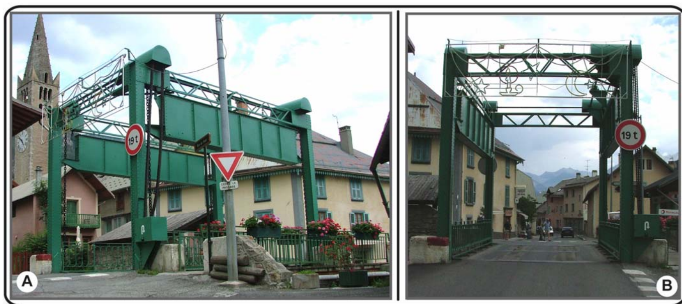
Figure 112: (A & B)- 15/07/2006. Pont-levis du torrent de Sainte-Elisabeth construit au début du 20 ème siècle.
