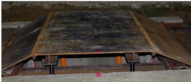
Figure 5-4 : Plaque métallique articulée [Camp, 2008].
