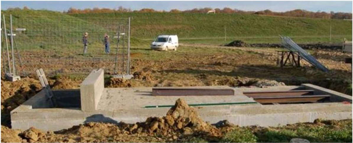
Figure 5-3 : Fosse en béton armé avec emplacement de la plaque (à droite) [Camp, 2008]
