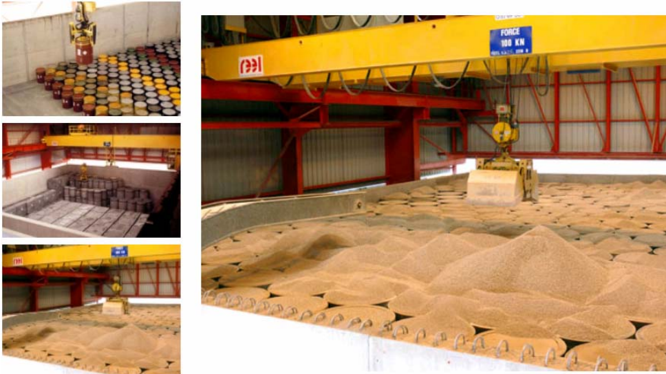
Figure 1-6 : Mise en place des couches des déchets dans le centre l'Aube
