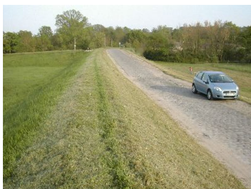
Déversoir de la Chapelle-aux-Naux
