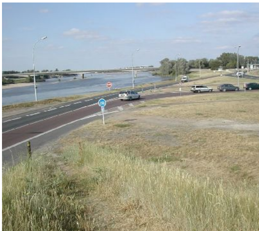
Déversoir de la Bouillie après le sens interdit
