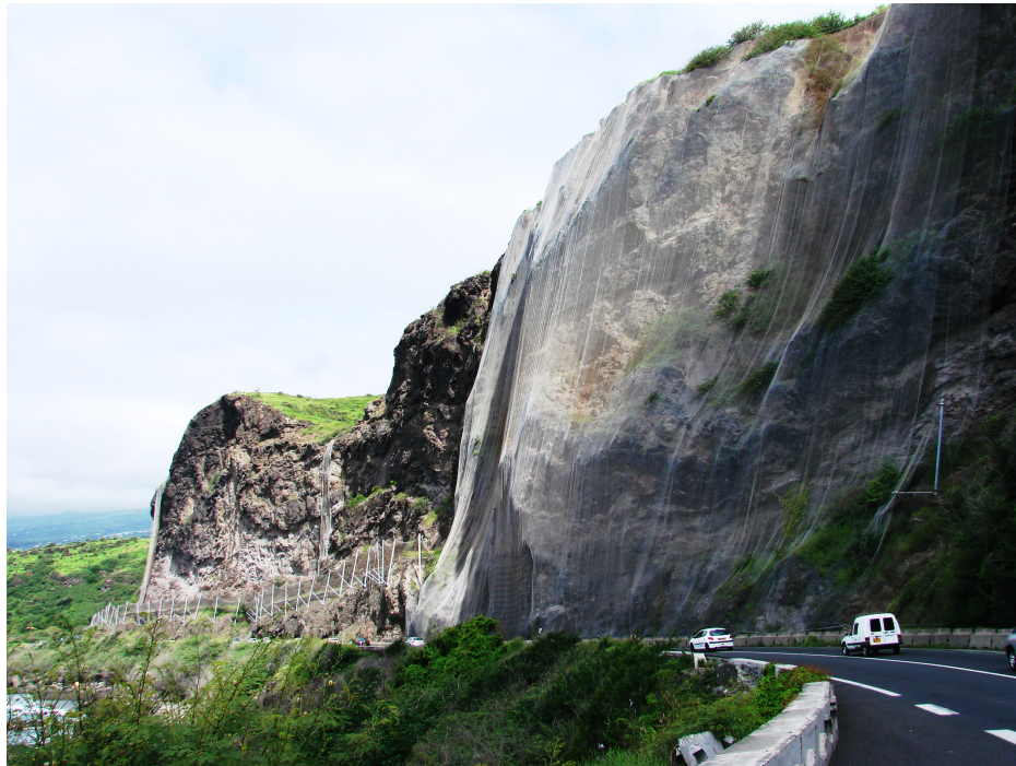
Filets de protection sur la "route du littoral" Île de la Réunion
