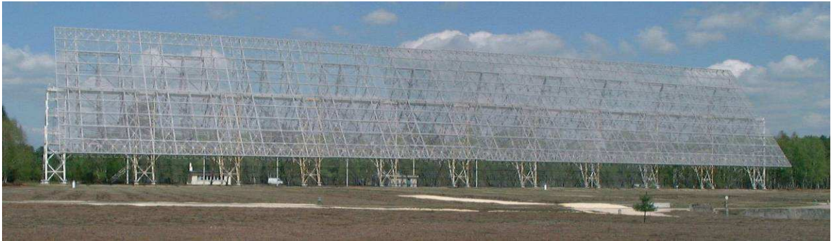
Figure III.2 : vue frontale du miroir mobile de 8000 m 2 (200 m x 40 m)
