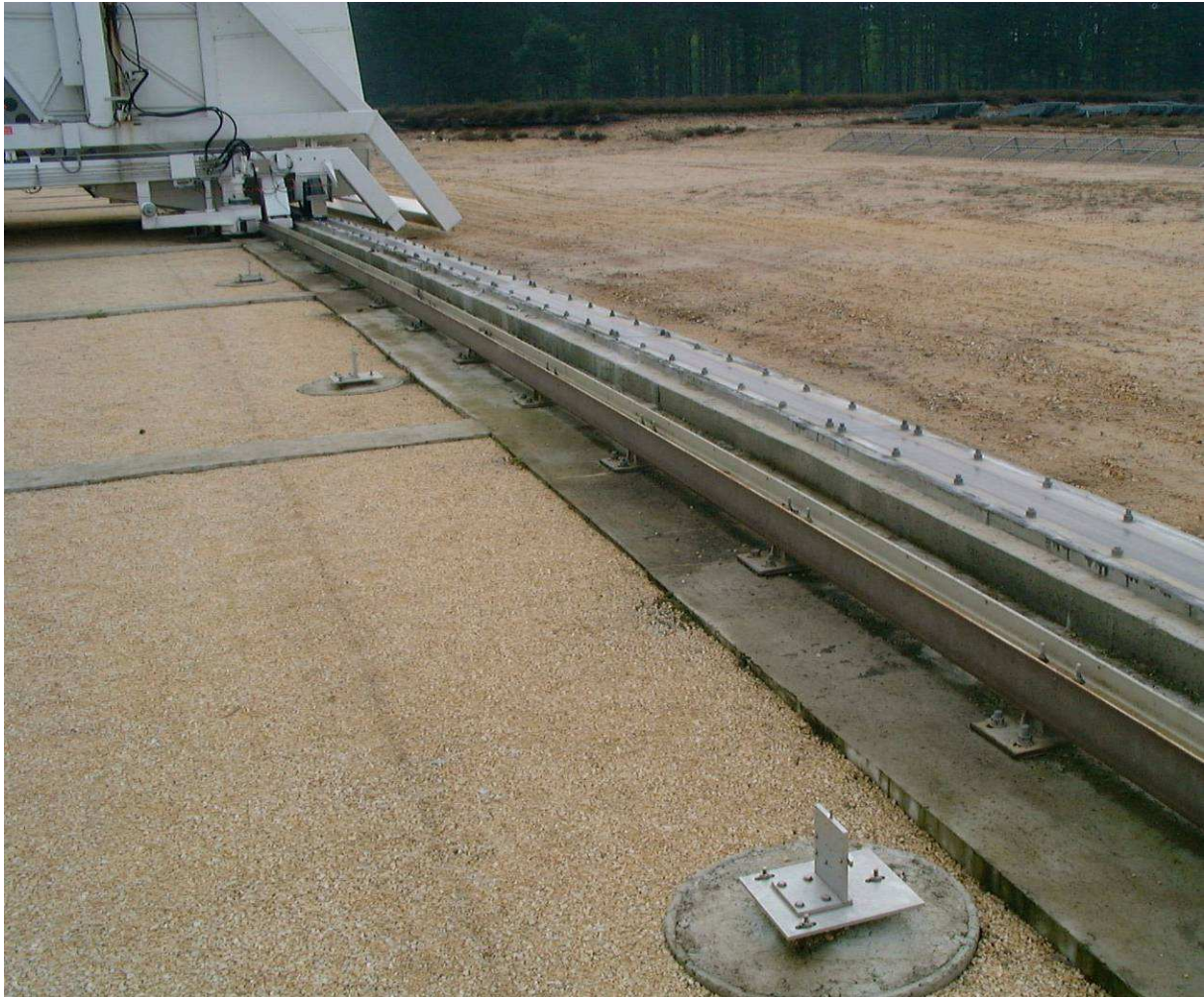
Figure III.8 : voie focale avec points de référence tous les 6 mètres
