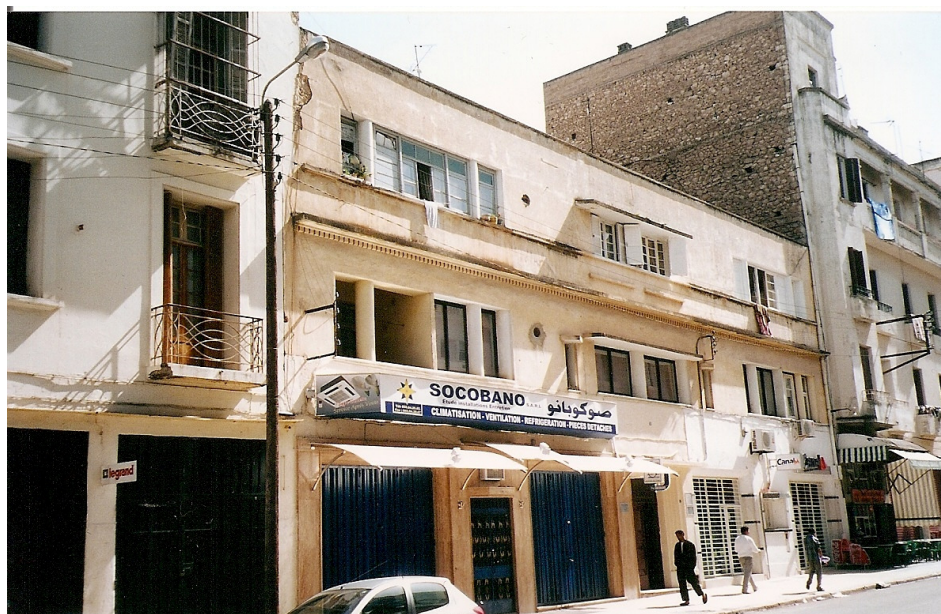
Immeuble, lot n°160 du secteur d'HC, Rue de Serbie, 2005.
