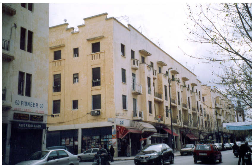
Immeubles de la CFAO
