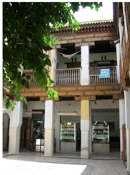
Galerie commerciale, côté sud, 2006.
