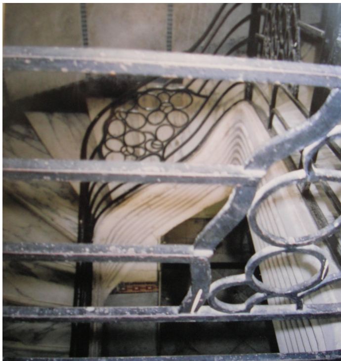
Immeuble Braunschvig, Avenue de France, Escalier principal, 2004.
