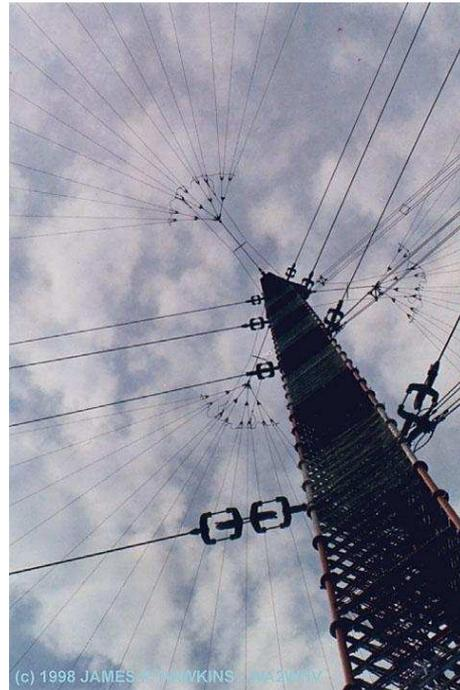
*Figure I.16* Isolateurs et Maintien des câbles de l'antenne Goliath
