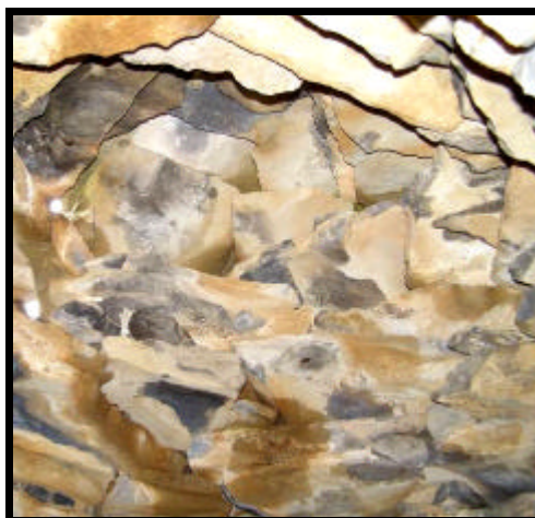
Figura 2.4. Techo de piedra de cabaña de pastor (Cinc Torres; Castelló) (Foto: A. Solé)
