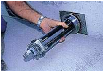
FIGURE 1.4 – Renforts antisismiques réalisés avec des AMF : une "première" mondiale appliquée au tympan de la basilique St-François.
