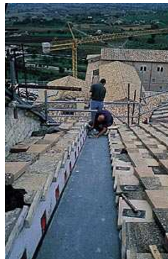
FIGURE 1.5 – Travail de préparation de la mise en place des dispositifs AMF.
