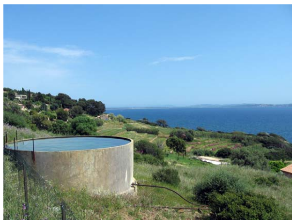
Restanques en déprise. Carqueiranne (83)
