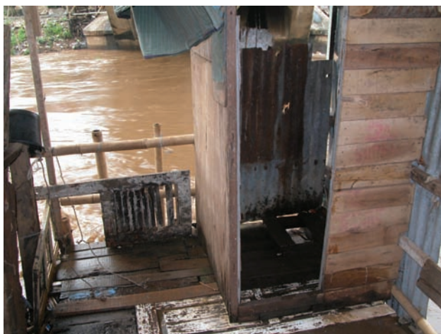
Figure 4.19. Latrines au dessus de la rivière Ciliwung à Bukit Duri (cliché P. Texier, avril 2006).
