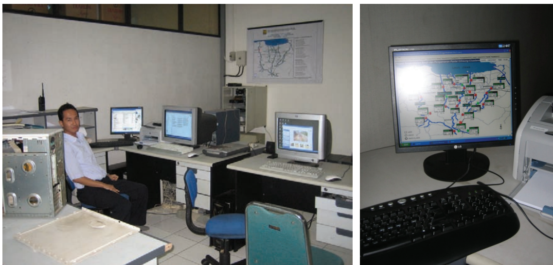
Figure 6.7. Centre télémétrique de surveillance des précipitations et des débits (Poste d'astreinte radio, point de départ de l'Early Warning System ou alerte précoce) au PWS Ciliwung Cisadane Project , à Cawang (Jl Kalimalang). (Clichés P. Texier, février 2007).
