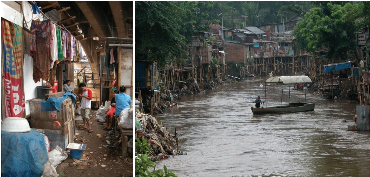
Figure 4.35. Habitat non permanent sur les bords de la rivière Ciliwung à Bukit Duri (à gauche, habitat construit sous le pont de Manggarai ; à droite, berge de la Ciliwung avec maisons sur pilotis (cliché P. Texier, mars 2006).
