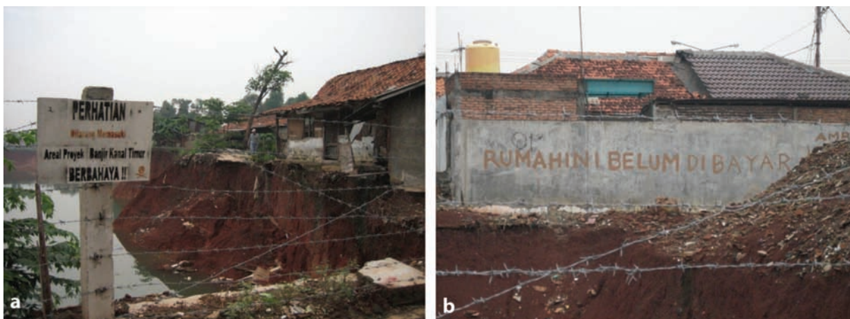
Figure 6.17. Berges du BKT en construction. a : on peut lire sur la pancarte « Attention, interdiction d'entrer, zone de projet du BKT, DANGER ». b : sur le mur endommagé d'une maison encore habitée au bord d'une berge meuble mise à nu sensible aux glissements de terrain, il est écrit par ses occupants : « Cette maison n'a pas encore été indemnisée » (Clichés P. Texier, février 2007).
