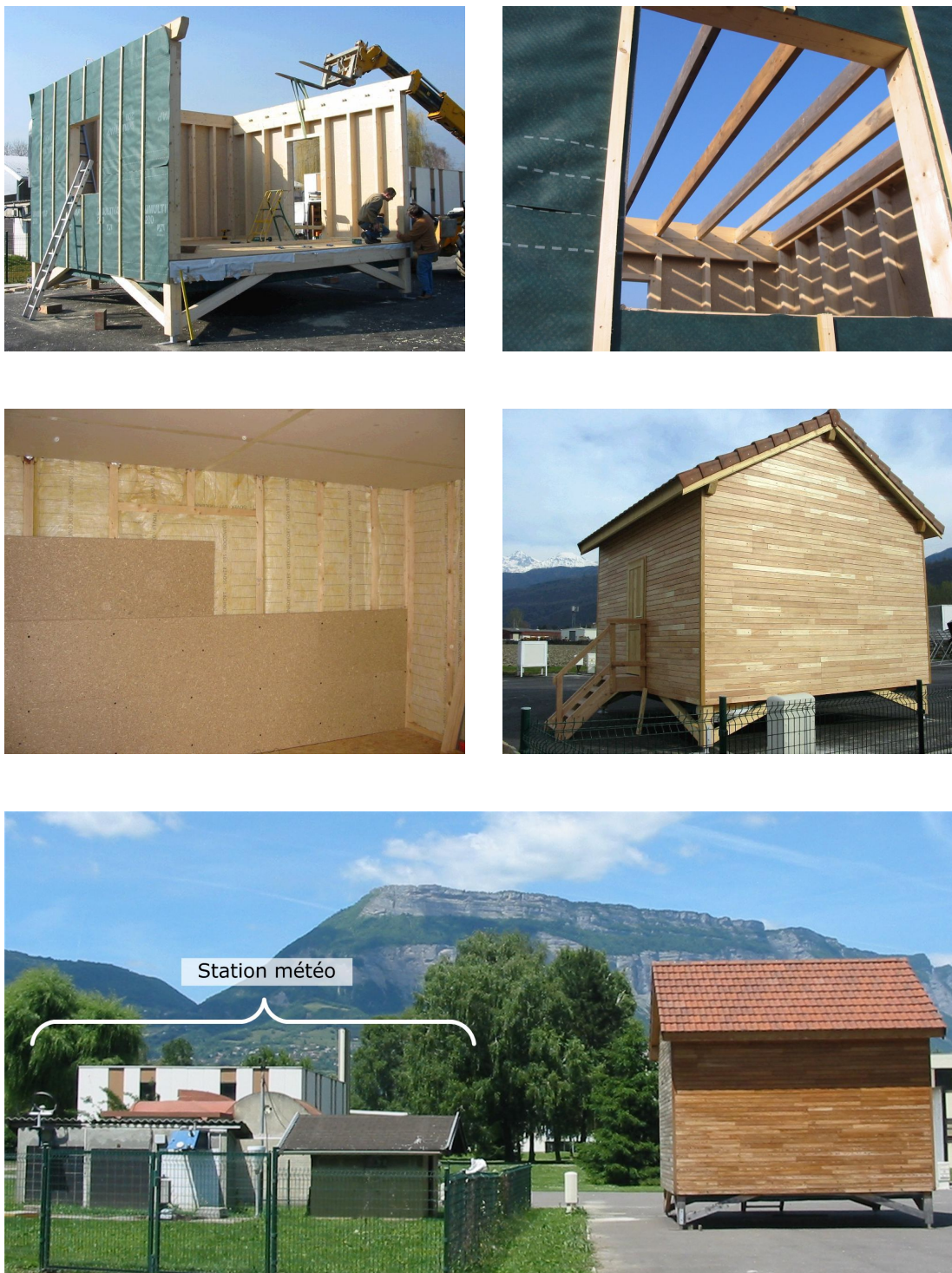
FIG. 2.1 : Photographies illustrant la construction et l'environnement de la cellule
