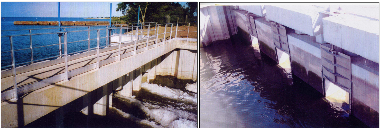
Photos 43 et 44 : barrage situé sur la digue séparant les prés salés du bassin interne. A marée haute, l'eau salée entre à travers quatre vannes indépendantes – ici, trois sont visibles et ouvertes – laissant apparaître des clapets qui s'abaissent sous son poids. Le niveau d'eau dans le bassin, lors de cette marée à fort coefficient, est supérieur à celui de la zone inondée. Le barrage peut être emprunté par les promeneurs (Clichés : M-F. Perrin, juin 2008).
