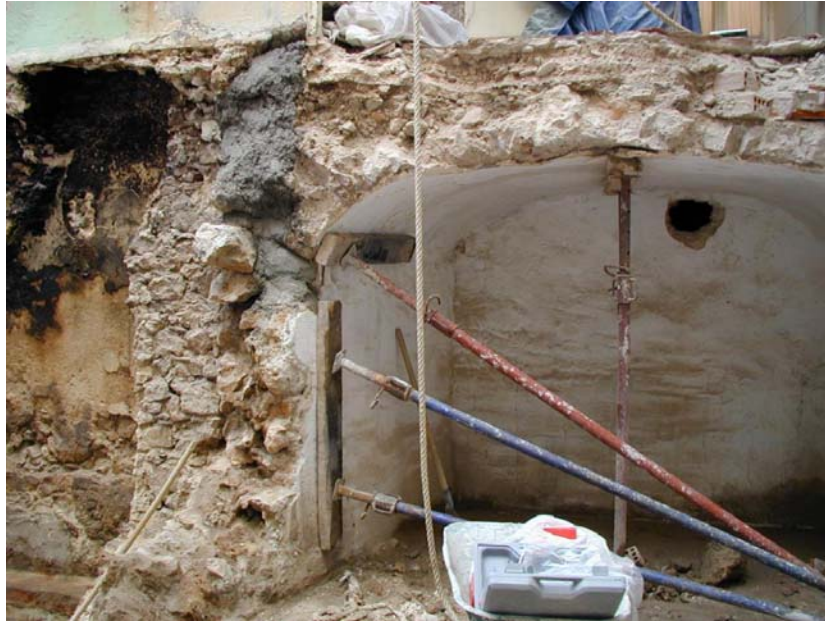
Figure 98 : Coupe réalisée dans les murs de l'immeuble situé dans la vieille ville sur le Rocher à l'angle de la rue de Vedel et de la rue Emile de Loth lors de sa réhabilitation. Photo des soubassements (cliché : O. Arnulf).
