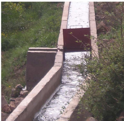
Ouvrage de transversement équipé de vannes sur le canal N'Oufilla de Rbat bétonné en 2001 (cliché : Fardau, mai 2002)
