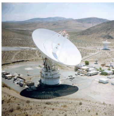
FIG. 1.12 – Antenne de 70m de diamètre du Deep space Network. La puissance émise par une telle antenne est de 2 à 400 kW, la puissance reçue typique est de 10^{-15} W. On estime qu'un niveau de bruit de -215 dBW/Hz vers 10 GHz est acceptable pour le fonctionnement des antennes. Tirée du site du DSN
