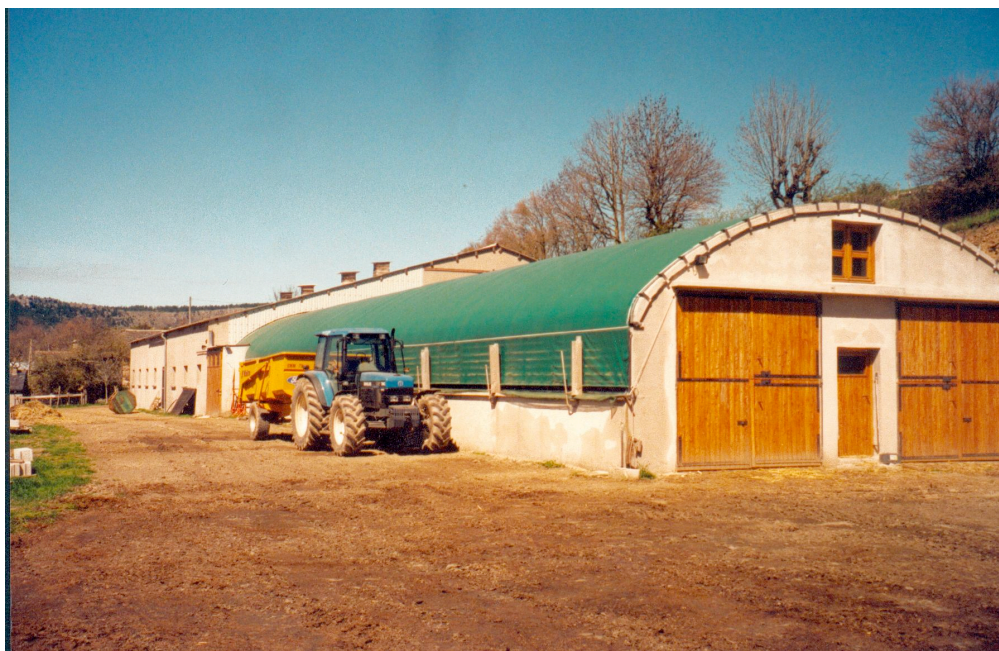
Photo 9. La bergerie de l'éleveur E, moderne, mais économe à la construction, bien aérée et éclairée avec sa base bétonnée et son toit « tunnel ».
