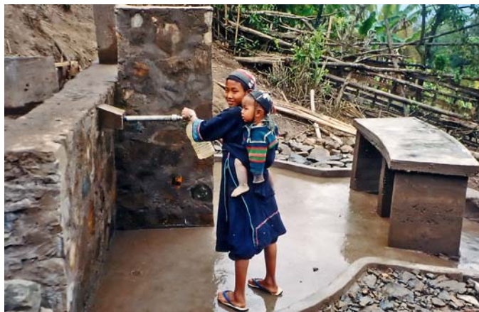
Photo 12 : Adduction d'eau villageoise (Nampongsang Kao, 2003)
