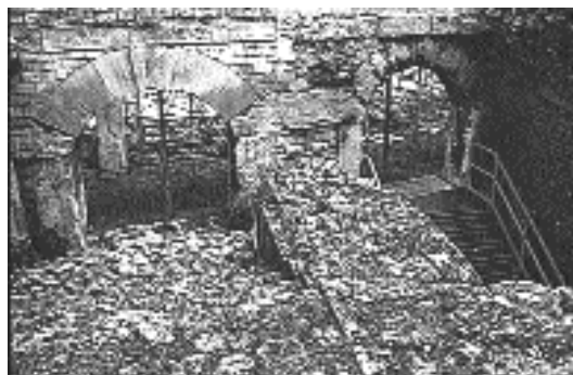
Fig. 503. L'un des escaliers métalliques dressés à l'amphithéâtre d'Arles suivant l'ancienne disposition d'accès entre la galerie du rez-de-chaussée et celle d'entresol. (Phot. V. Chevrier.)
