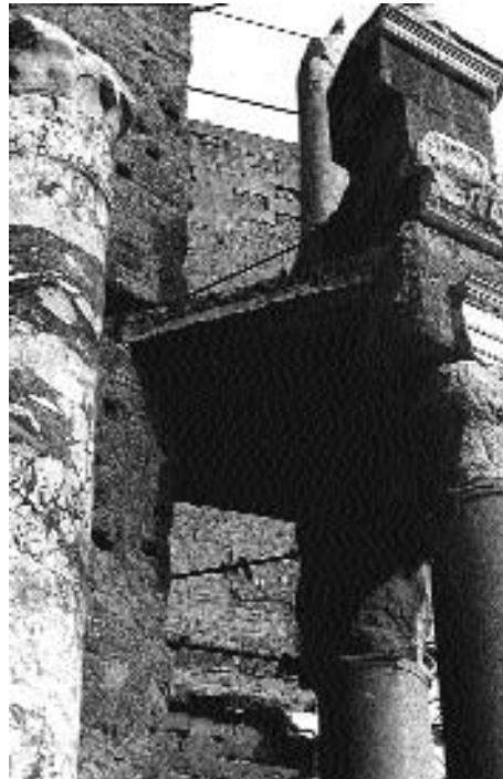
Fig. 525. Les colonnes dressées par J. Formigé devant la porte royale du théâtre d'Orange et maintenues par des tiges de fer ainsi qu'un « plateau » de ciment. (Phot. V. Chevrier.)
