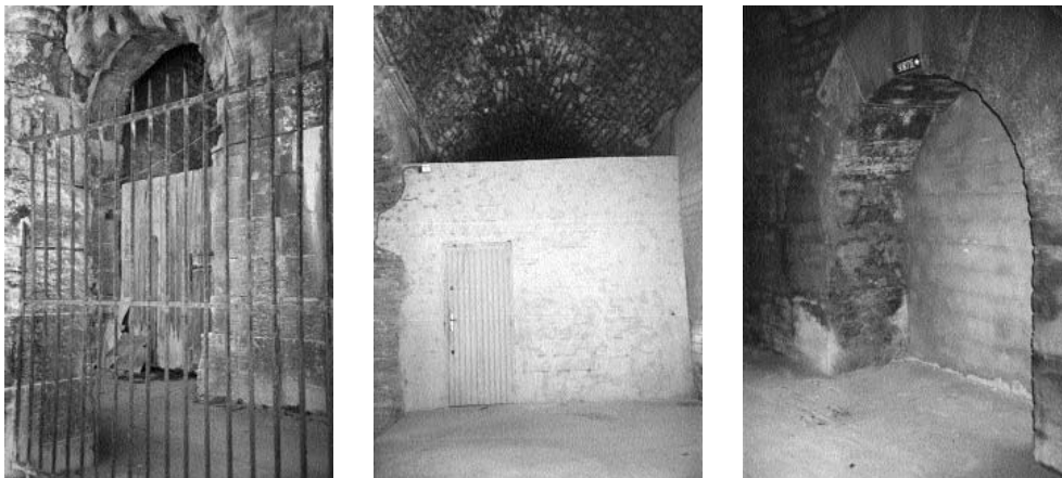
Fig. 406. Quelques travées de l'amphithéâtre d'Arles fermées à l'aide de portails de bois ou de murs de béton munis d'une porte permettant l'accès à un local technique. (Phot. S. Delarue.)
