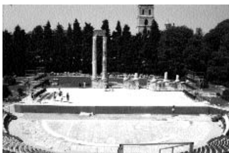
Fig. 416a. L'estrade actuelle du théâtre d'Arles montée à chaque début de saison en avant des deux Veuves et couvrant la fosse du rideau. (Phot. V. Chevrier.)
