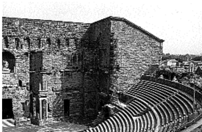
Fig. 479. Aménagement actuel de cinq rangs de gradins démontables contre le mur de la première praecinctio du théâtre d'Orange. (Phot. V. Chevrier.)
