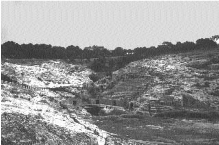
Fig. 383. L'amphithéâtre de Cagliari montre particulièrement bien l'utilisation de garde-fous en fer pour assurer la sécurité des vestiges autant que celle du public. (Phot. P. Pala.)
