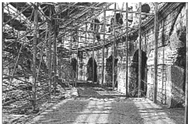
Fig. 488. L'emprise des échafaudages métalliques sur la galerie d'entresol de l'amphithéâtre d'Arles. (Phot. V. Chevrier.)
