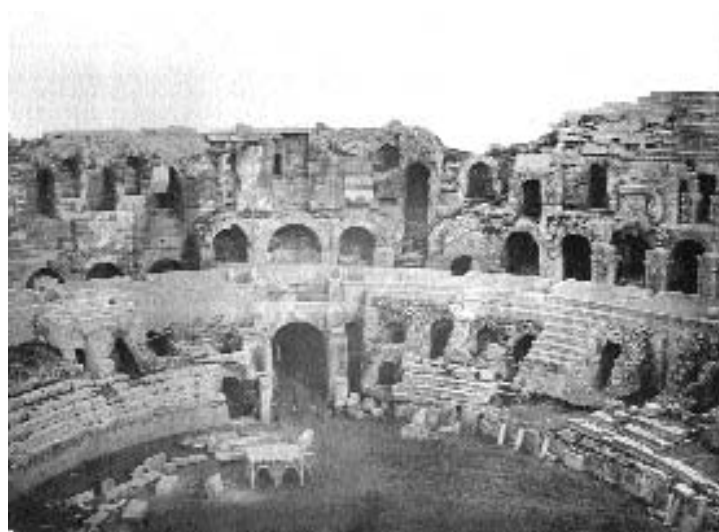
Fig. 293. Les premières interventions sur la cavea de l'amphithéâtre de Nîmes. Maçonnerie de l'extrados des voûtes de la galerie intérieure, entrée est, vers 1875. (Phot. Musée du Vieux Nîmes.)
