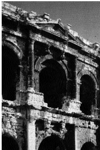
Fig. 343. La façade nord de l'amphithéâtre de Nîmes : hormis les protomes de taureaux, le rapport arc/entablement apparaît très similaire à celui du Colisée, fig. 55.
