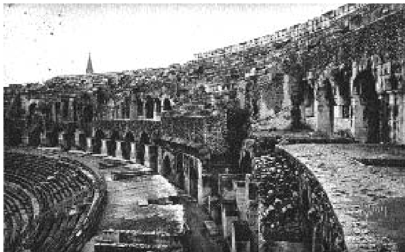
Fig. 301. Le nivellement des parties hautes de la cavea de l'amphithéâtre de Nîmes, côté sud, vers 1920. (Carte postale, phot. Yvon, fonds personnel.)
