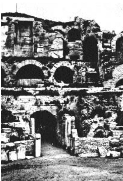
Fig. 304. Vue intérieure de l'amphithéâtre de Nîmes, et les « brèches du podium » de part et d'autre de la grande entrée orientale, vers 1850. Le mur d'enceinte du podium a été remonté en avant de ces brèches sans doute au tout début du XIX e siècle. (Phot. fonds privé M. Pradel, Nîmes.)
