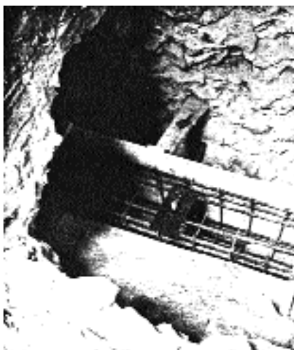
Fig. 332. Blocage au-dessus d'un linteau de la galerie du second niveau à Nîmes devant recevoir une poutre de ciment armé. (Phot. A. Chauvel, M.H.F., 1938.)
