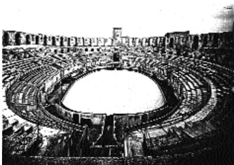
Fig. 403. Le callejon des Arènes d'Arles en partie reconstruit en béton armé, 1930. (Phot. A. Véran, arch. C.M.H., 330/5.)
