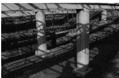
Fig. 426. Quelques-uns des socles de béton pris dans les vestiges du théâtre de Vaison et soutenant l'armature de fer du plateau de scène. (Phot. V. Chevrier.)
