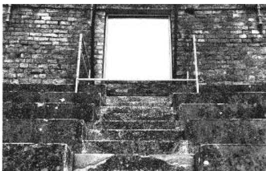
Fig. 438. La vitre fermant le vomitoire central de la première præcinctio du théâtre d'Orange qui fait désormais office de régie. (Phot.V.Chevrier.)
