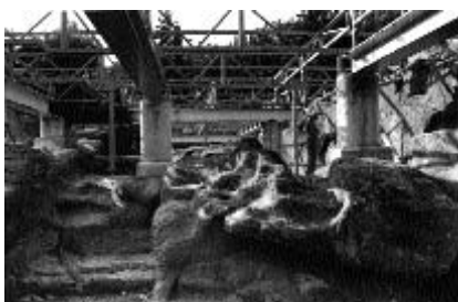
Fig. 426. Quelques-uns des socles de béton pris dans les vestiges du théâtre de Vaison et soutenant l'armature de fer du plateau de scène. (Phot. V. Chevrier.)
