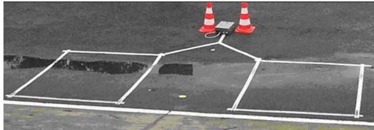
FIG. 1.2 – Les boucles électromagnétiques sont ici collées sur la chaussée. Pour plus de résistance, il est nécessaire de raboter le revêtement pour y intégrer la bobine.
