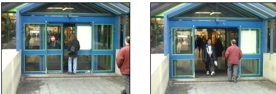
Figure 24 : Sas - de l'extérieur vers l'intérieur - [en janvier]
