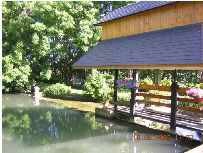
Figure 80 - Vannes de décharge et déversoir du moulin de Matron
