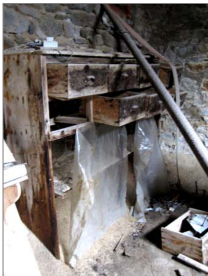
Figure 157 : PHOTO, L'ARMOIRE DANS LA CHAUFFERIE
