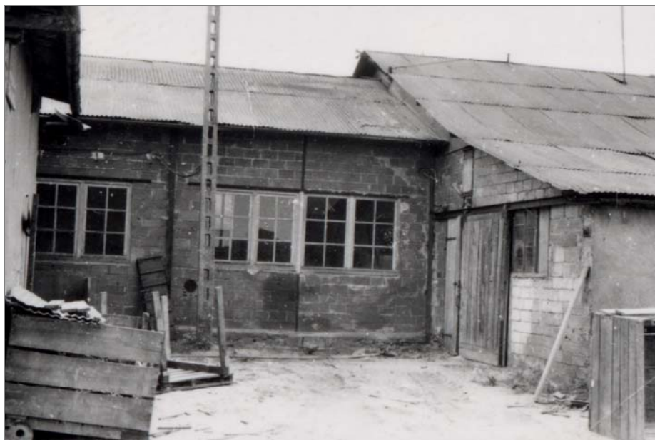
Figure 63 : 1977 – LES BATIMENTS DE LA SCIERIE DE LA ROCHE-EN-BRENIL SANS MODIFICATION DEPUIS 1930
