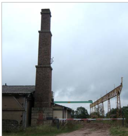
Figure 68 : 2007 – SCIERIE DE LA ROCHE-EN-BRENIL : ANCIENNE CHEMINEE ET PONT
