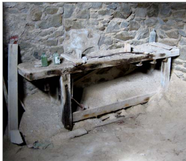
Figure 158 : PHOTO, L'ETABLI DANS LA CHAUFFERIE
