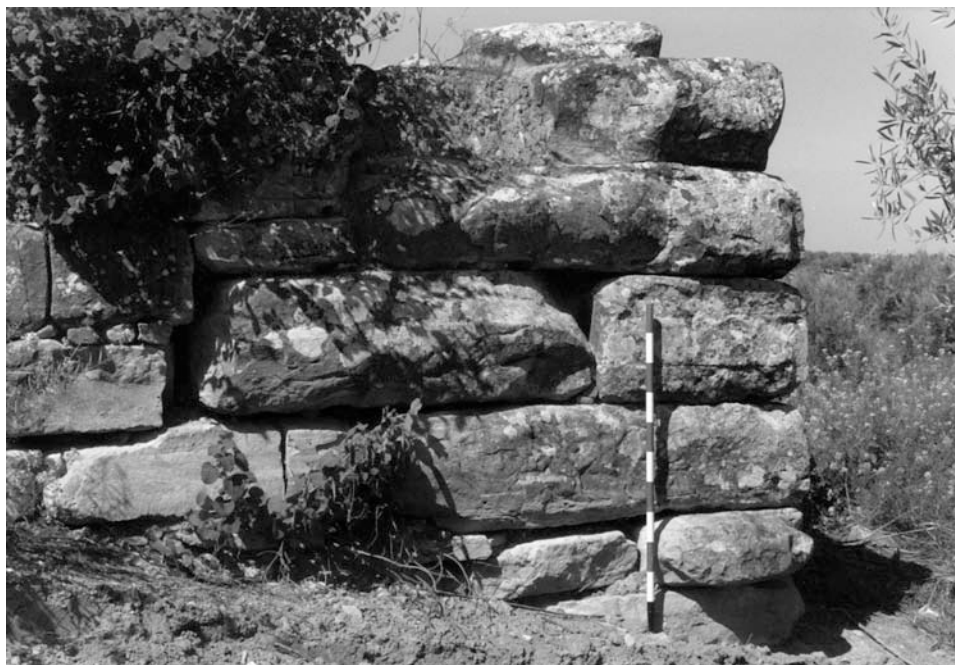
Fig. 8. La maison forte d'El Comendador (Porcuna, Jaén). Une feuillure d'angle est visible.
