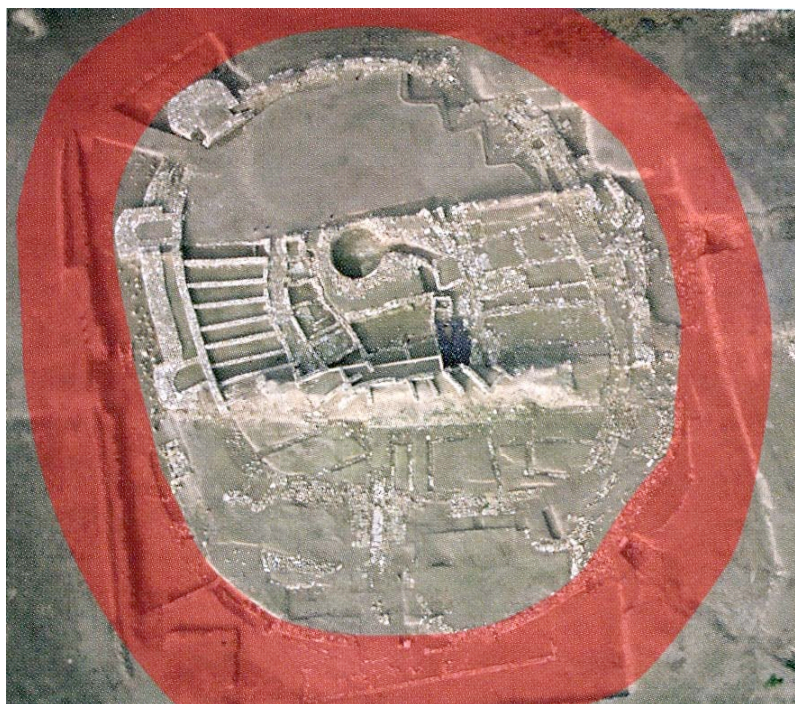
Fig. 4. Vue aérienne d'Els Vilars, d'après JUNYENT et al. (le tracé du fossé est indiqué en rouge).
