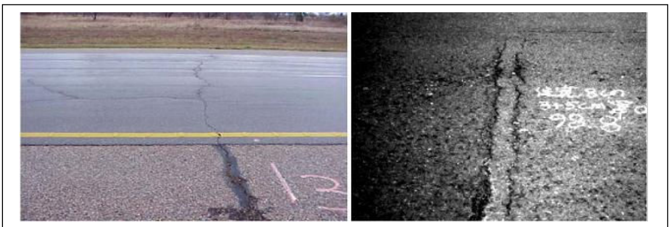
Figure 1.4 – Deux types de fissure réflexive [Zhou 2005]
