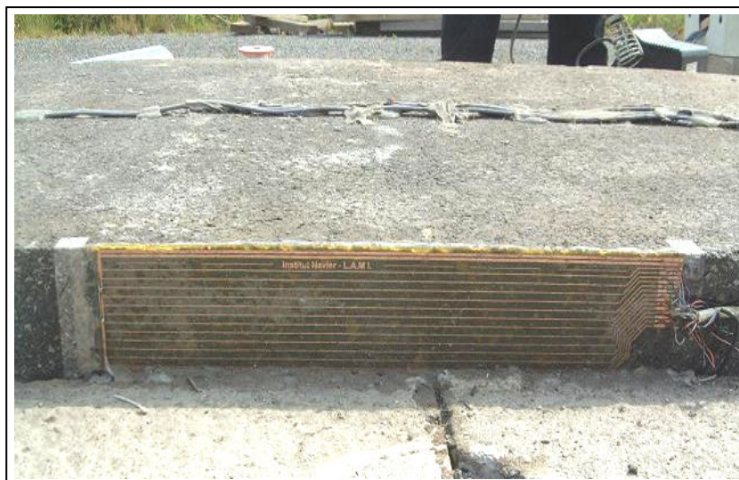
Figure 2.37 – Jauges de fissuration de 30 cm de longueur
