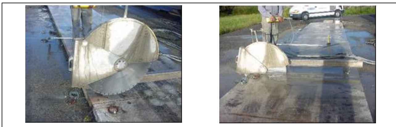
Figure 2.7 – Sciage des joints de la planche d'essai préparée pour l'essai de fissuration avec l'équipement FABAC
