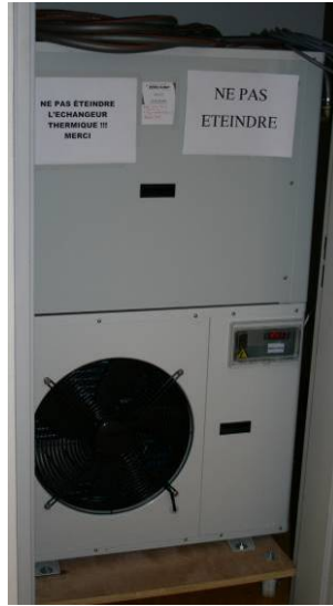
Fig. 6 Groupe de génération d'eau glacée.
