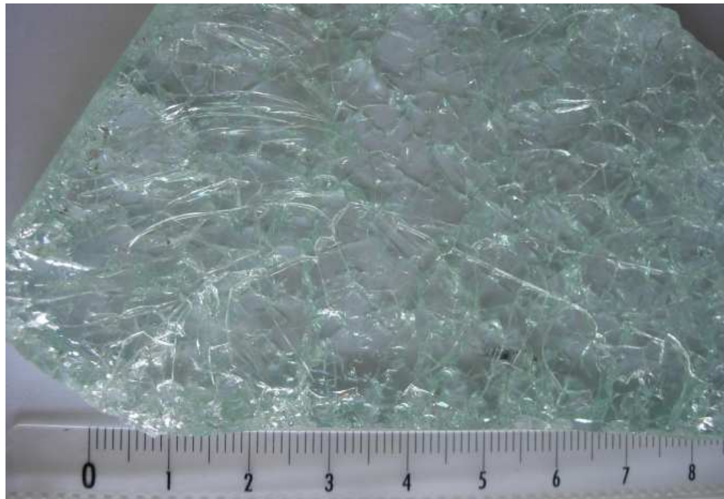
plaque de pyrex fissurée
