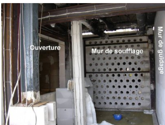
(e) Vue rapprochée de la façade du compartiment (essais 3 et 4)
