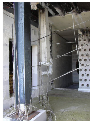
(f) Vue rapprochée de la façade du compartiment (essais 5 et 6)
