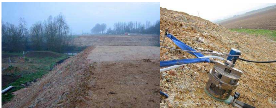
Figure 3.16 : Photo du remblai prise sur sa crête et un essai en cours sur le talus
