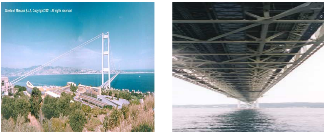
FIG. 5 – Le projet de pont suspendu Stretto di Messina et le pont suspendu Akashi-kaikyo
