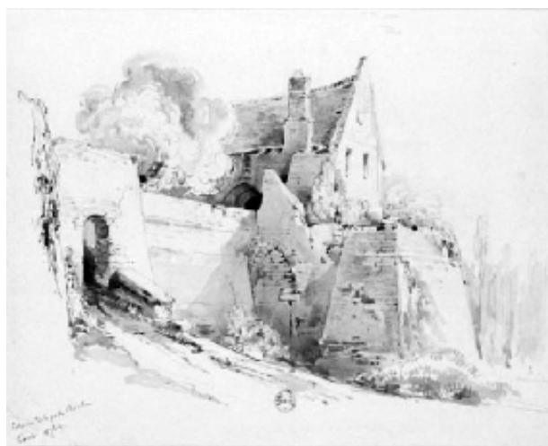
Figure 54 : Poterne de la Porte Rouline à Tours. Dessin réalisé par Bergeron, le 18 septembre 1842. (BNF : IFN-7741517)
