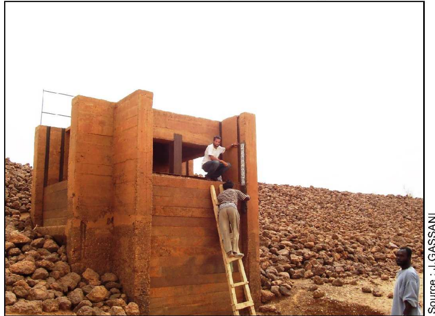
Photo 26 : Relevés linimétriques au barrage de Mâle
