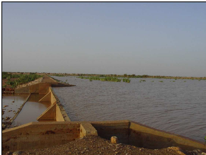
Photo 1 : Barrage sur le bassin versant d'Aleg (31/08/06)
