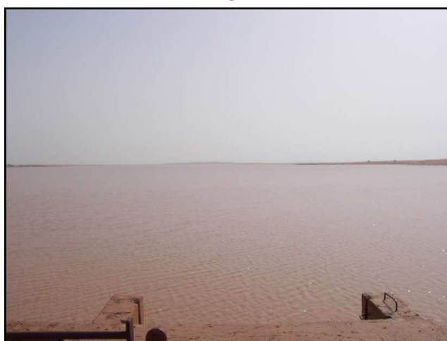
Photo 2 : Barrage et lac de Mâle
