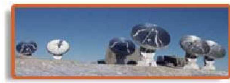
FIG. 1.4 – L'interféromètre de l'IRAM - Plateau de Bure (France) avec ses 6 antennes de 15 m de diamètre. La longitude et la latitude de l'interféromètre sont de 05^{\circ} 54 \text{ min } 28.5 \text{ sec} - Est et 44^{\circ} 38 \text{ min } 02.0 \text{ sec} - Nord.
