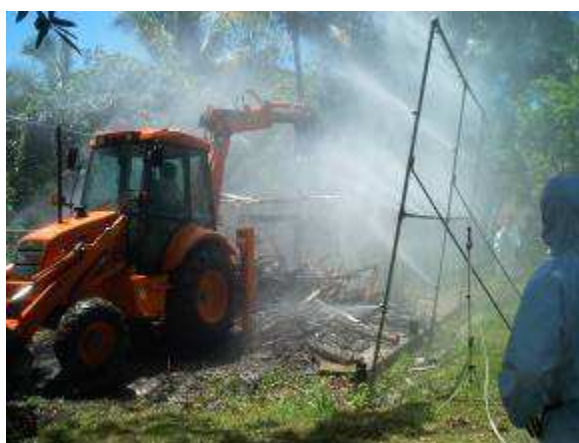
Photographies 99, 100, 101 et 102 : Destruction des maisons recouvertes de trémolite par la société chargée de l'opération (Photos Patrick Flotat)
