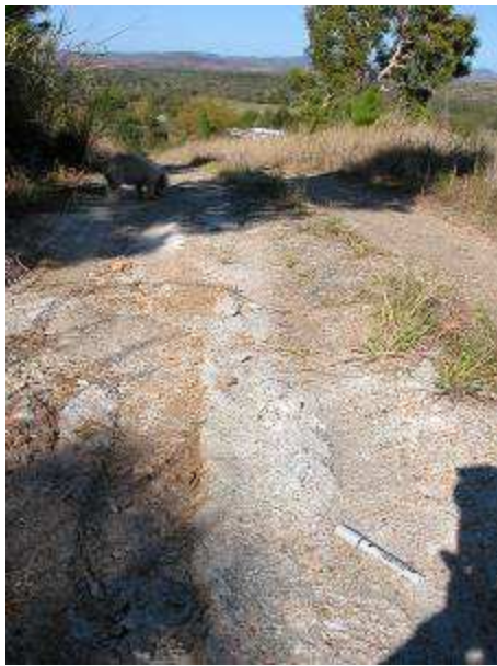
Chemin d'accès au château d'eau
